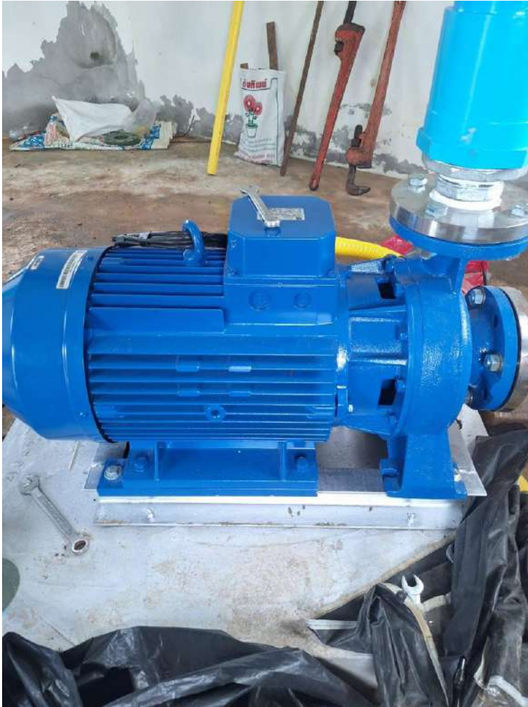
๖.๔ ติดตั้งปั๊มสูบน้ำดีทดแทนตัวเก่าที่เสียในวงเงิน ๘๕,๕๒๘.๐๐ บาท
