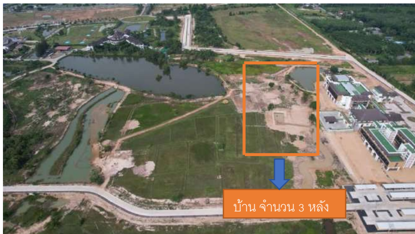
ภาพที่ 5 บ้าน จำนวน 3 หลัง ถูกรื้อถอน
