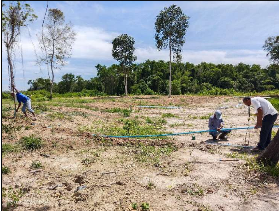
รูปที่ 20 ดำเนินการติดตั้งระบบน้ำเพิ่มเติมในพื้นที่รหัสแปลง 1 - 1
