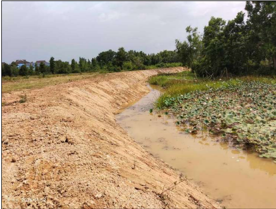
รูปที่ 16 การขุดลอกคูน้ำบริเวณทิศเหนือของรหัสแปลง 1 - 3
