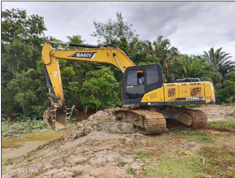
รูปที่ 25 ขณะทำงานลงพื้นที่ตรวจสอบและประสานงานกับผู้รับจ้าง
