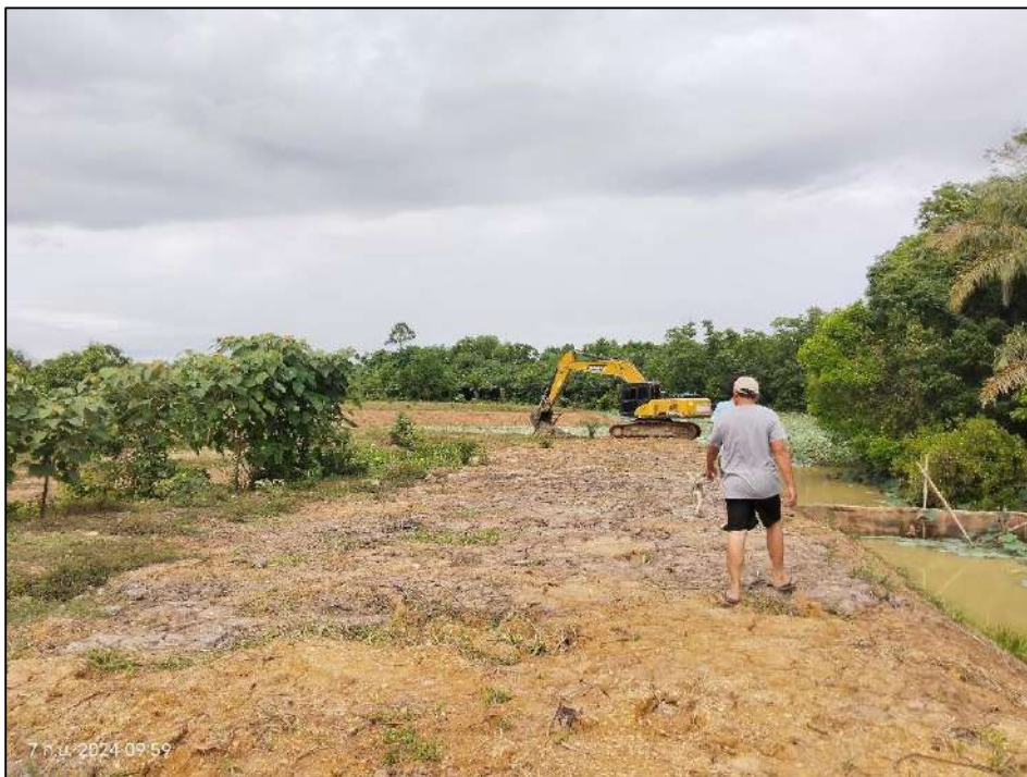
รูปที่ 26 ขณะทำงานลงพื้นที่ตรวจสอบและประสานงานกับผู้รับจ้าง
