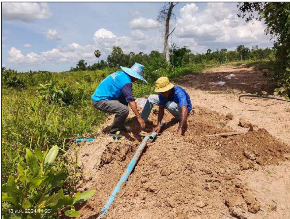
รูปที่ 21 ดำเนินการติดตั้งระบบน้ำเพิ่มเติมในพื้นที่รหัสแปลง 1 - 1
