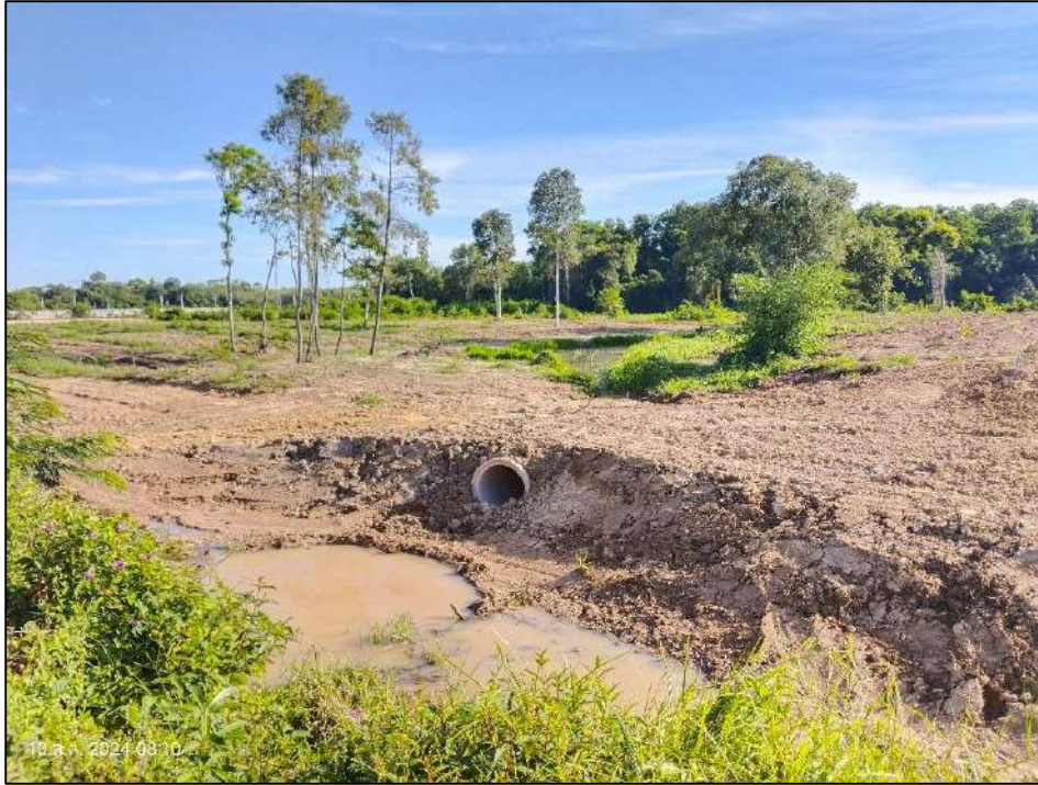
รูปที่ 18 ดำเนินการวางท่อซีเมนต์ ในพื้นที่รหัสแปลง 1 - 1
