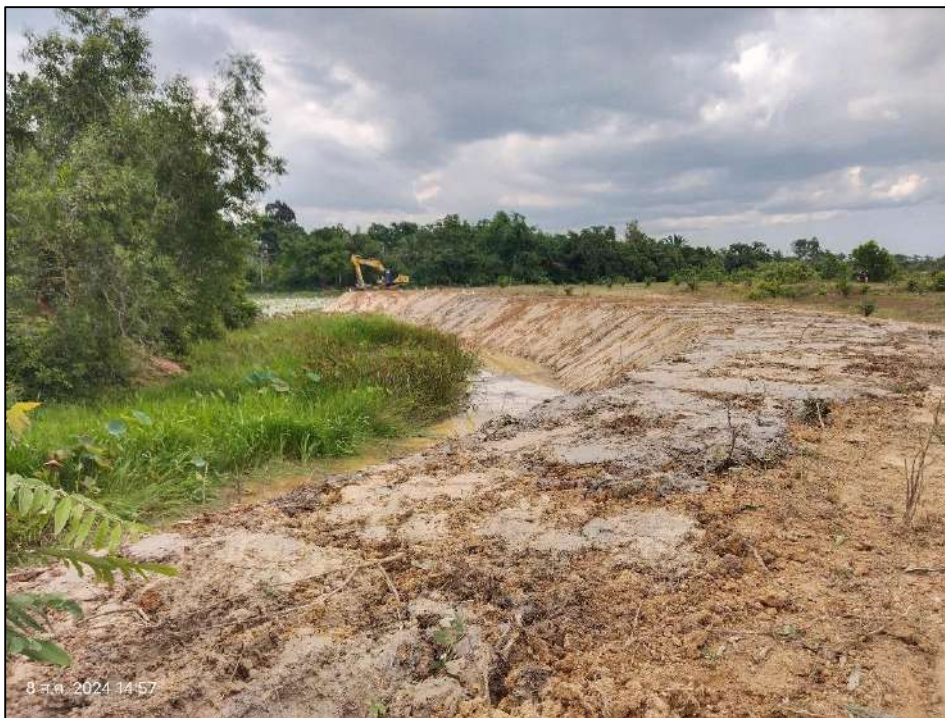
รูปที่ 17 การขุดลอกคูน้ำบริเวณทิศเหนือของรหัสแปลง 1 - 3
